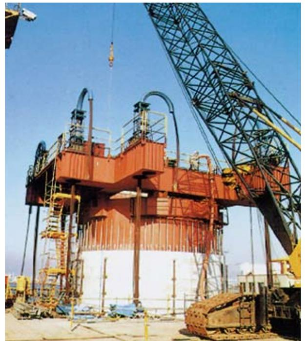
概要：円形  $\phi 10.0\text{m} \times 80.0\text{m}$  15基 圧入力 3,000ton 500tジャッキ×8台
