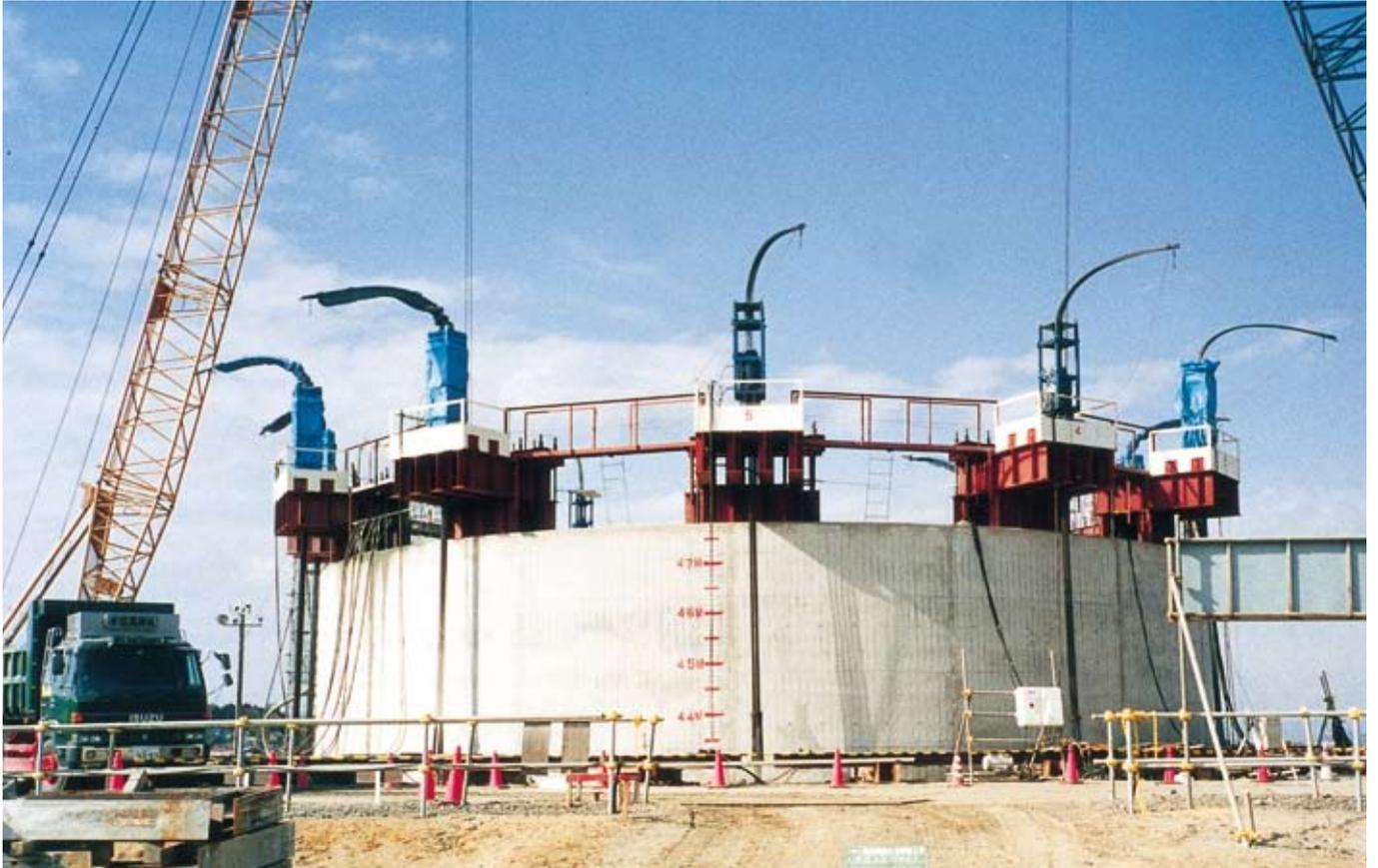
概要：円形  $\phi 23.1\text{m} \times 47.8\text{m}$  1基 圧入力 2,500ton 400tジャッキ×10台
