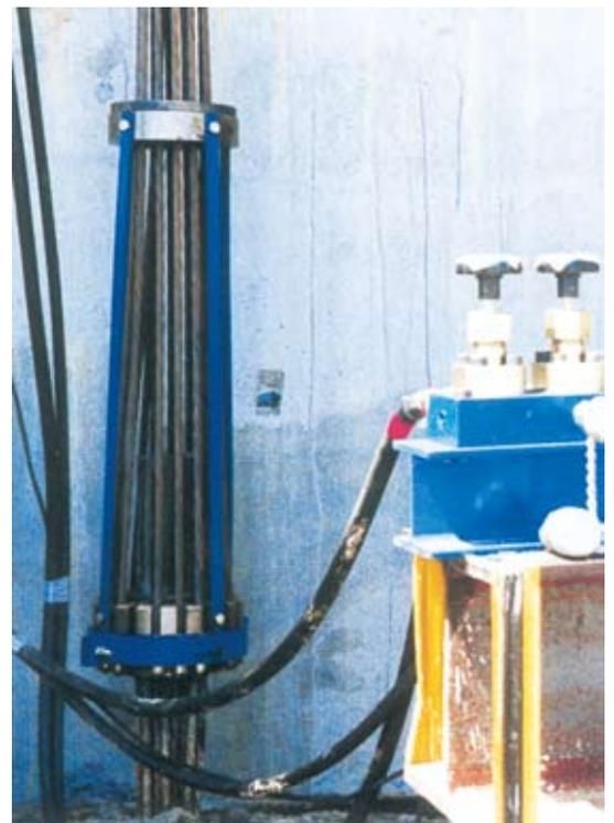
グラウンドアンカーとPCストラッドの接続金具及び分岐バルブ
