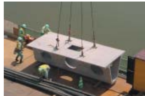
桁の吊り上げ準備
