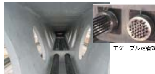
主ケーブルの設置
