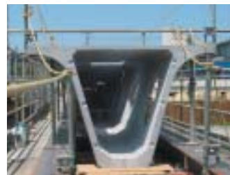
桁の設置状況
