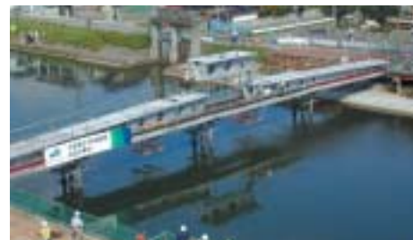
桁の架設
