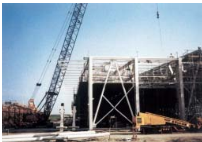
構台上で組み立て中の屋根
