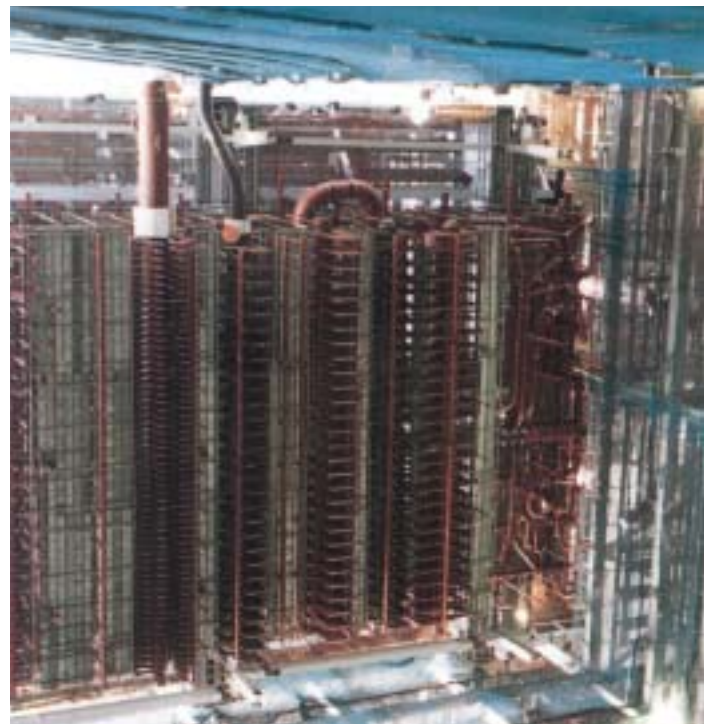
トップガーダー下に取付けたボイラー部材
