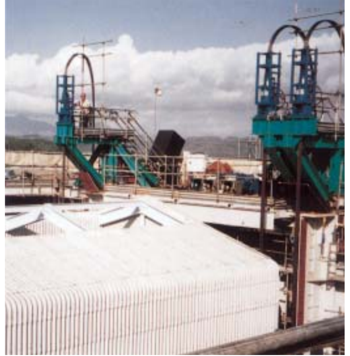
リフトアップ中のトップガーダー屋根部
