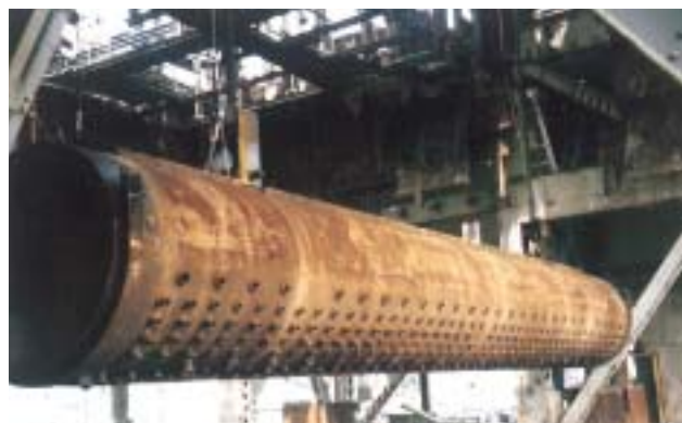
重量140tの蒸気ドラムの降下解体
