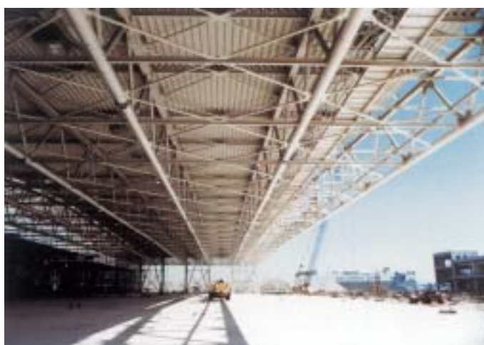
構台前面に引き出された屋根
